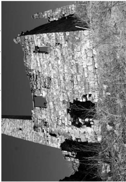
фото 3. Вид с ЮВ на главный фасад башни жилой №5 в сел. Пийлинг Джейрахского района Республики Ингушетия. Дверной проем 1 яруса и оконные проемы 2 яруса. На втором этаже башни балкон №2. Фото Б.Х. Агафонова
